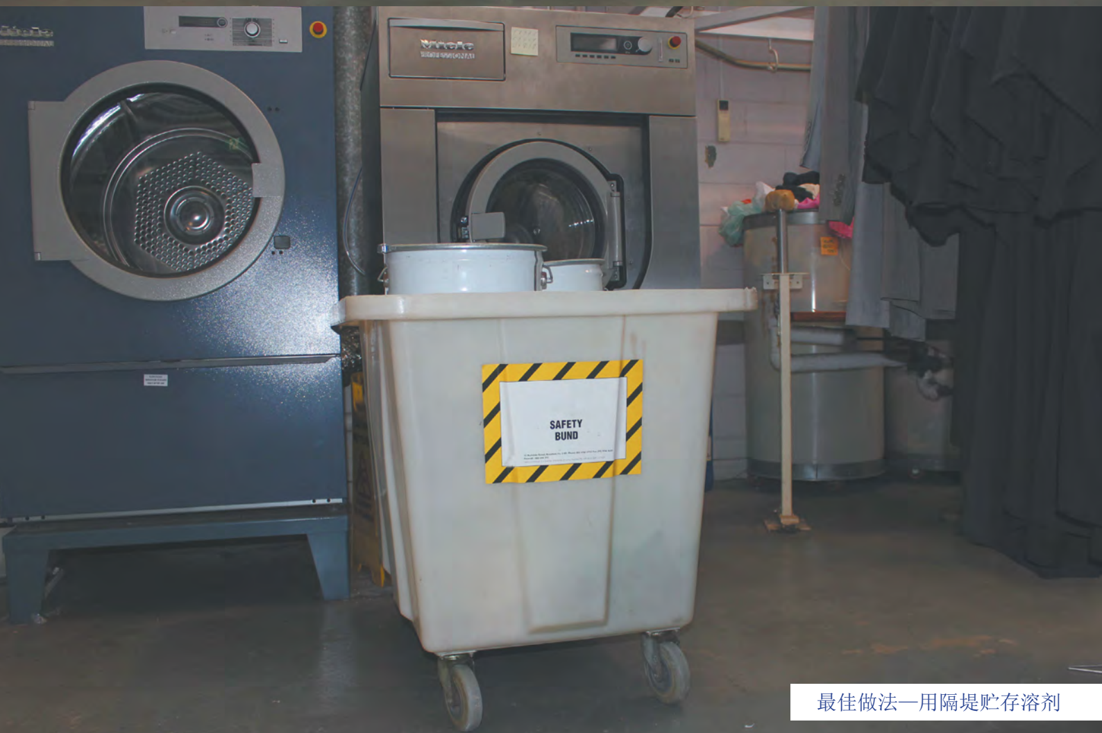
不良做法—溶剂贮存区没有隔堤或遏制保护
